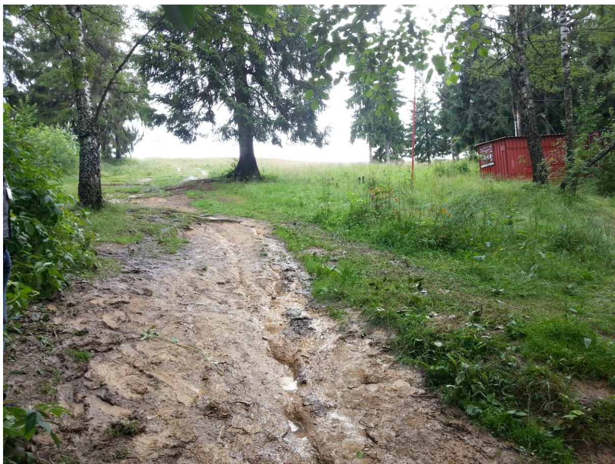
Fot. 1 Roślinność na terenie objętym opracowaniem
